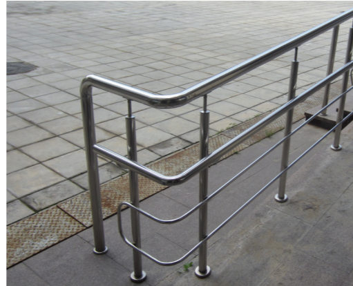
Ограждение входной группы бизнес-центра со стойками k751 и двойным поручнем из нержавеющей стали.
