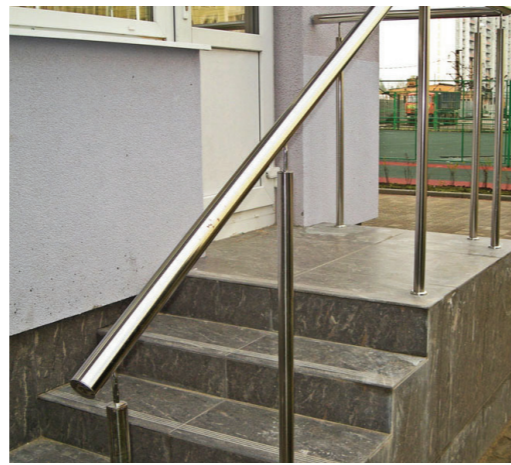
Ограждение крыльца эконом-вариант со стойками k702 и поручнем из нержавеющей стали Ø50,8мм.
