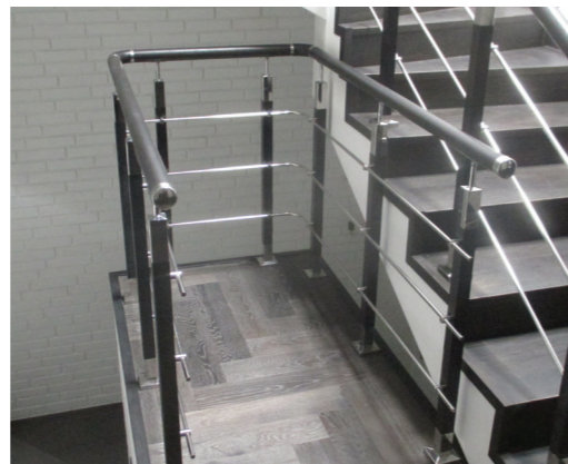
Ограждения со стойками k740-1. Вставки и поручень из дуба тонированы в черный цвет.
